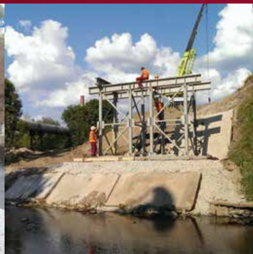
Pagaidu tilta starpbalstu uzstādīšana
