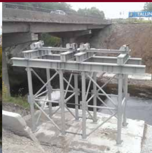
Pagaidu tilta starpbalstu uzstādīšana
